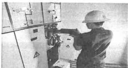
ทำการตรวจเช็ค Ring main unit
