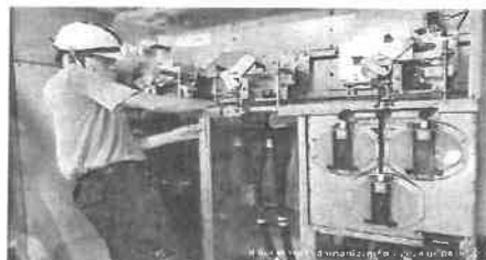
ทำการตรวจเช็ค Ring main unit
